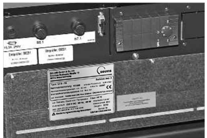
Abb. 12: Zusatztypenschild anbringen
