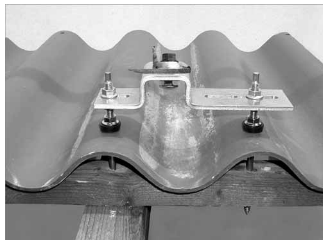
Fig. 59 : fixation sur toiture vissée (méthode B)
