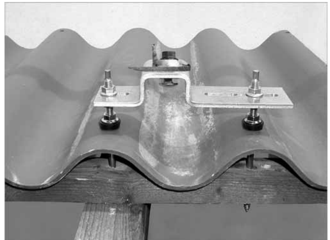
Afb. 69: Opbouw-dakbeugel gereed gemonteerd (methode B)
