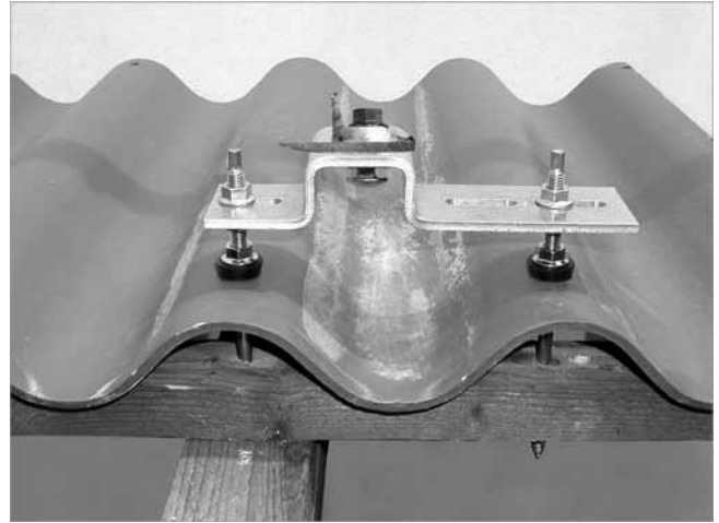
Abb. 9: Aufdachhalter verschraubt (Methode B)
