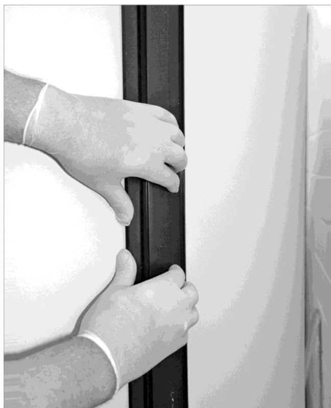
Afb. 8: isolatiegedeeltes sluiten
