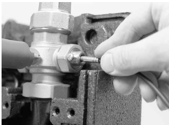
Afb. 19: aanvoertemperatuurvoeler monteren
