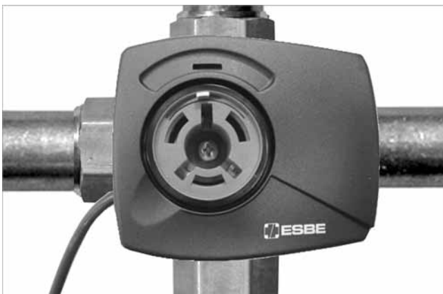
Abb. 4: Mischer mit Stellantrieb
